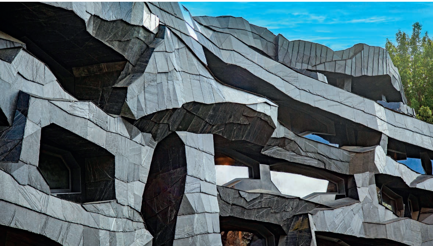
La Querola de Ordino, Andorra. Arquitetos: Ateliers Jean Nouvel, Ribas & Ribas Arquitectos e Jordi Sala. Foto: © Pepo Vázquez
