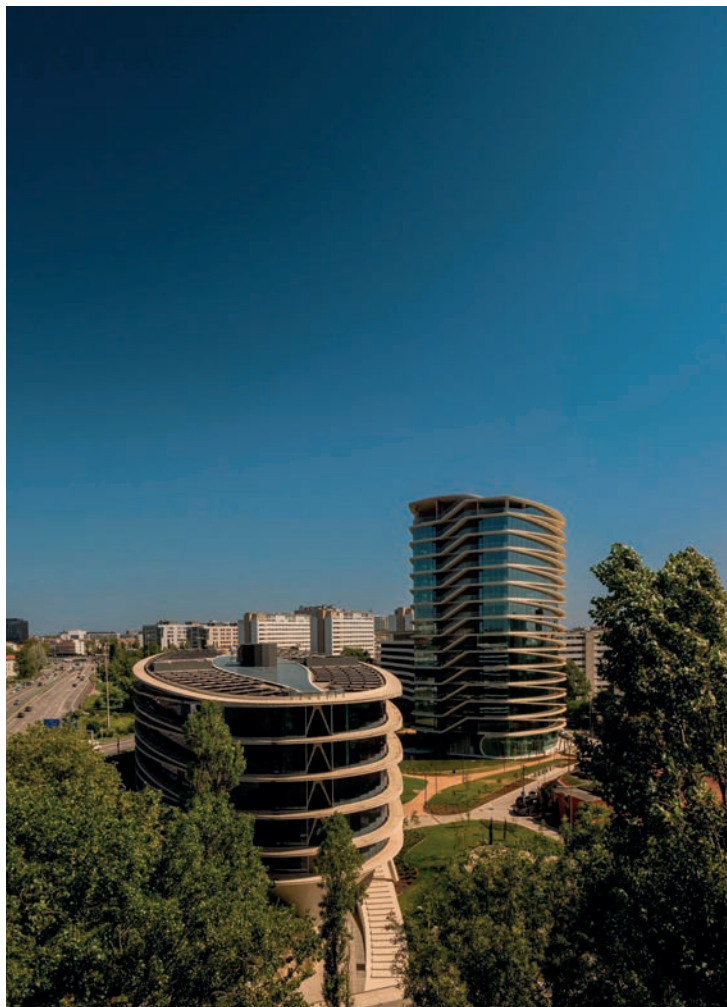
Exterior do edifício ICON Douro, Oporto. Foto: ©Fernando Guerra
